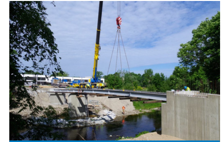
Sillakaare paigaldamine Ülejõe sillale, 11.06.19. Autor Valdur Vacht
